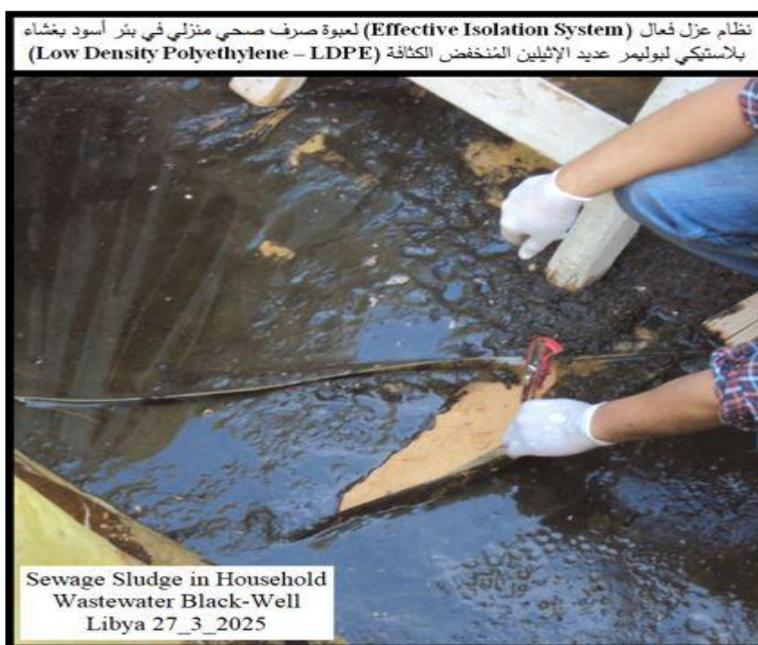
الشكل 9: ناتج تكوين الوحل اللزج الأسود بتراكم المُترسبات بعد تفريغ عبوة بئر الصرف الصحي المُغلف بعازل من مادة عديد الإثيلين المُنخفض الكثافة ( Low Density Polyethylene – LDPE) [14].
